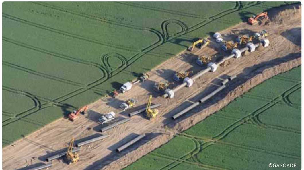
Bau der im Herbst 2013 komplett fertiggestellten Nordeuropäischen Erdgasleitung (NEL) zur Anbindung der Ostsee-Pipeline Nord Stream
